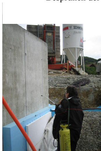
Besprühen der Betonwände
