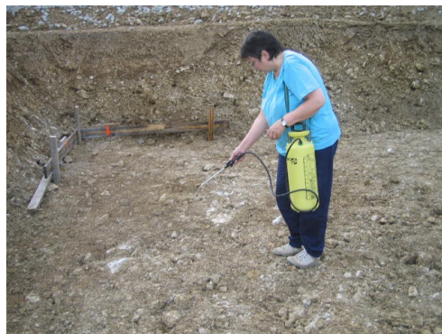
Besprühen der Baugrube mit EMA
