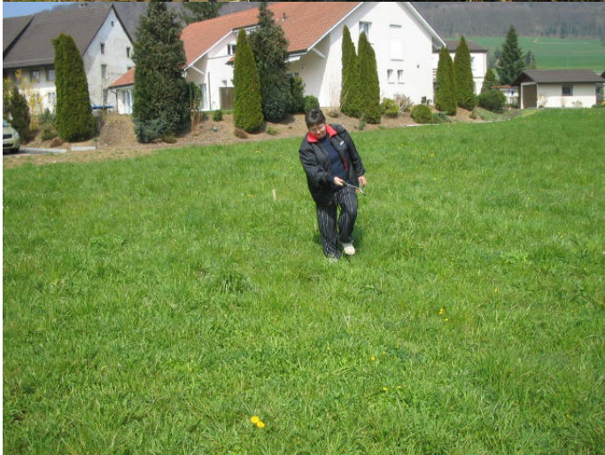
Aufstellen der Holzwände
